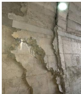
混凝土破损
