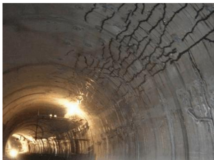
拱顶裂缝
